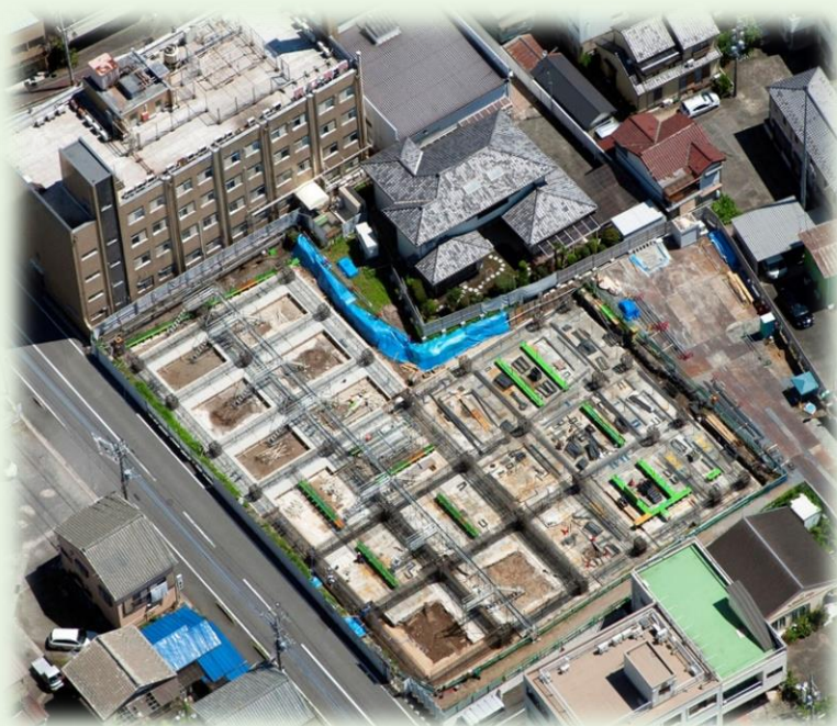
新病院建設現場 航空写真(7月17日撮影)
