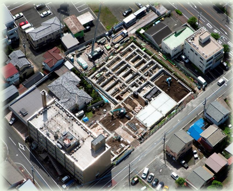
新病院建設現場 航空写真(8月19日撮影)
