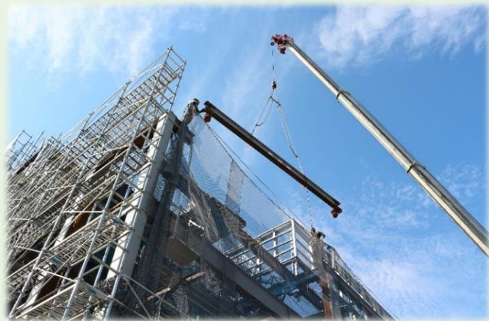
棟木吊り上げの様子 (10月8日撮影)
